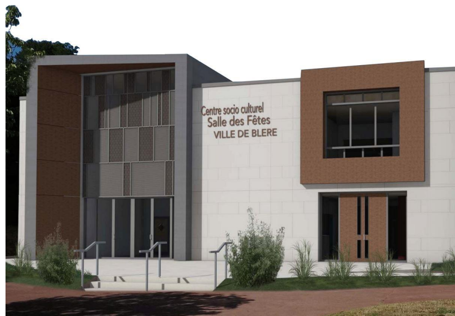
Le projet de centre socio-culturel à Bléré, en cours de construction
