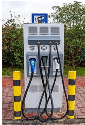
Figure 9 : Borne de recharge électrique multi-standards, Medenbach
